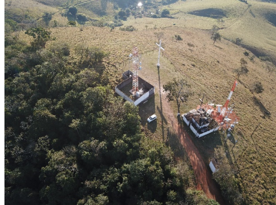
Figura 2 – Perspectiva do terreno, face noroeste.
