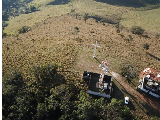
Figura 1 – Perspectiva do terreno, face norte.
